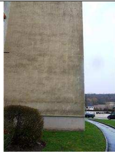
011 - PARTIES COMMUNES - Pignon PH10 : Enduit projeté PRE010
