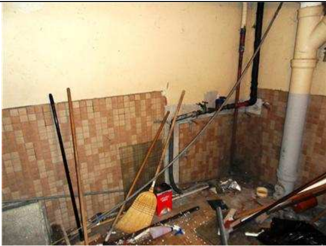
009 - PARTIES COMMUNES - Salle d'eau PH6 : Colle céramique PRE007
