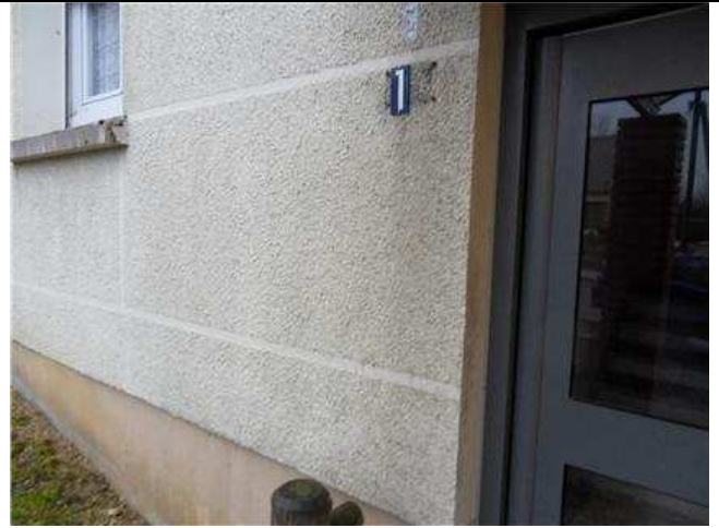
008 - PARTIES COMMUNES - Façades PH5 : Enduit peint PRE006
